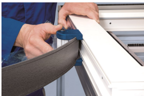
Ejemplo de instalación (CB): Montaje en ventana de PVC
